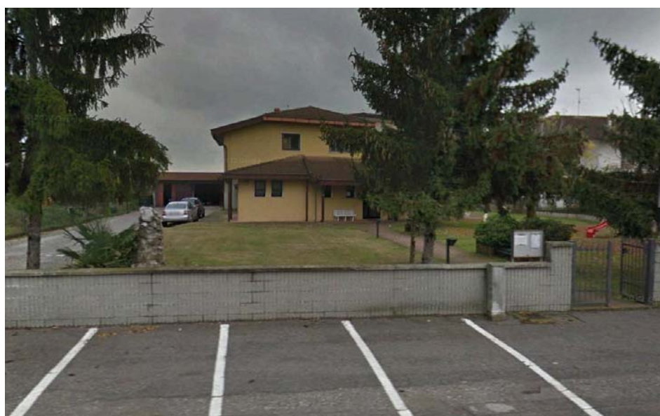
L'edificio che, in Cappella Cantone, ospita l'ambulatorio medico.
